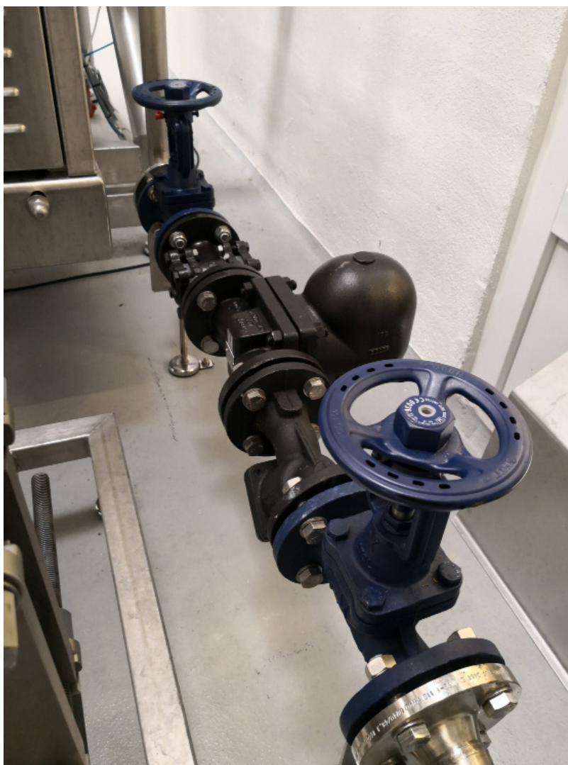
"Kondensat-tog" bestående af sædeventiler, snavssamler, vandudlader og skueglas.
